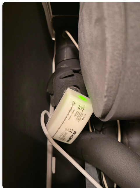
Frese 01-1856 — термический привод. Зелёный LED горит. Клапан открыт. Воды нет. Иронично.
