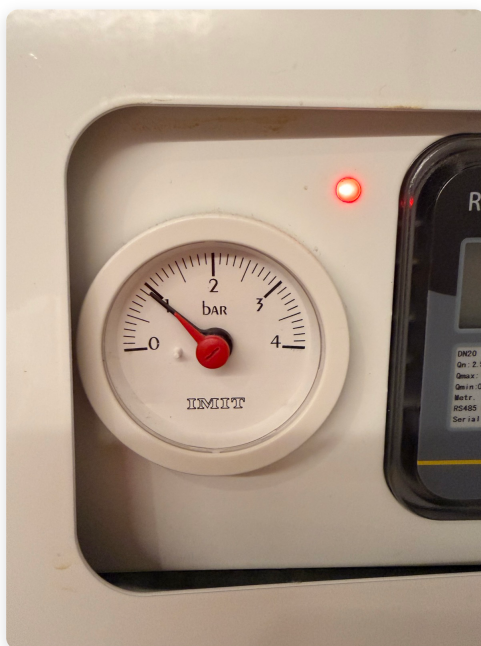
Манометр показывает ~0.7 бар. В норме 1.0–1.5. Рядом красный LED. Нервничаем.
