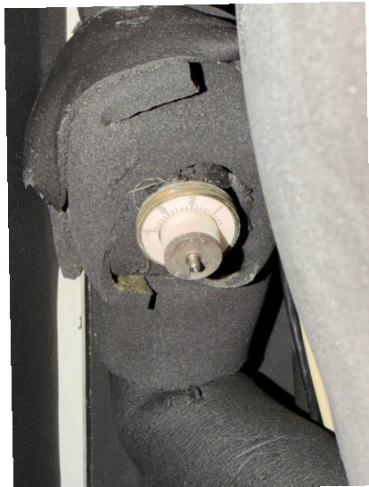
ВЕЩДОК № 1 Клапан охлаждения и тот самый шток.
